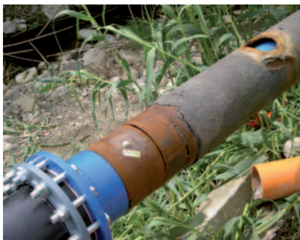
Raccordo terminale flangiato di un liner plastico composito, destinata al collegamento del tubolare con la tubazione esistente o con le tubazioni metalliche in genere
