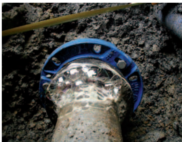
Dispersione da giunto canapa e piombo evidenziata da miscela di acqua e sapone
