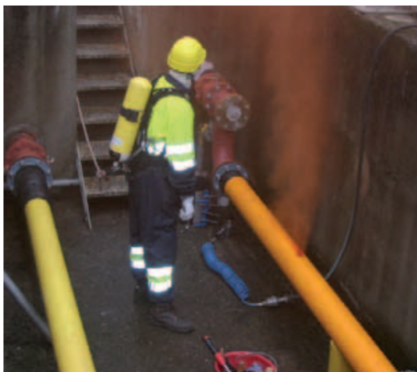
Intervento su tubo in PE Ø 180 mm
