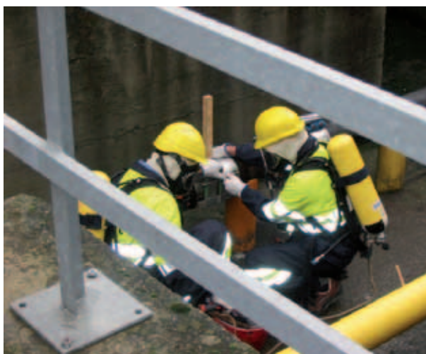
Intervento su tubo in g.s. Ø 150 mm
